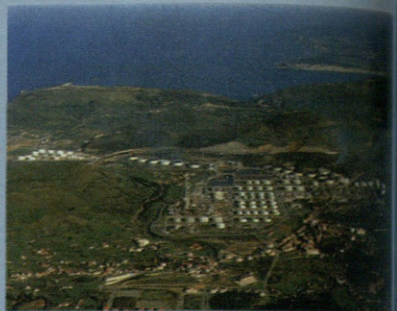
■ IGCC zentral termikoa.
