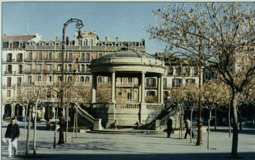
■ Gaztelu Plazak zuen itxura duela gutxi obrak hasi aurretik.
