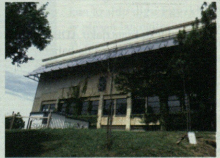
■ Instalazio termikoa kiroldegian.
