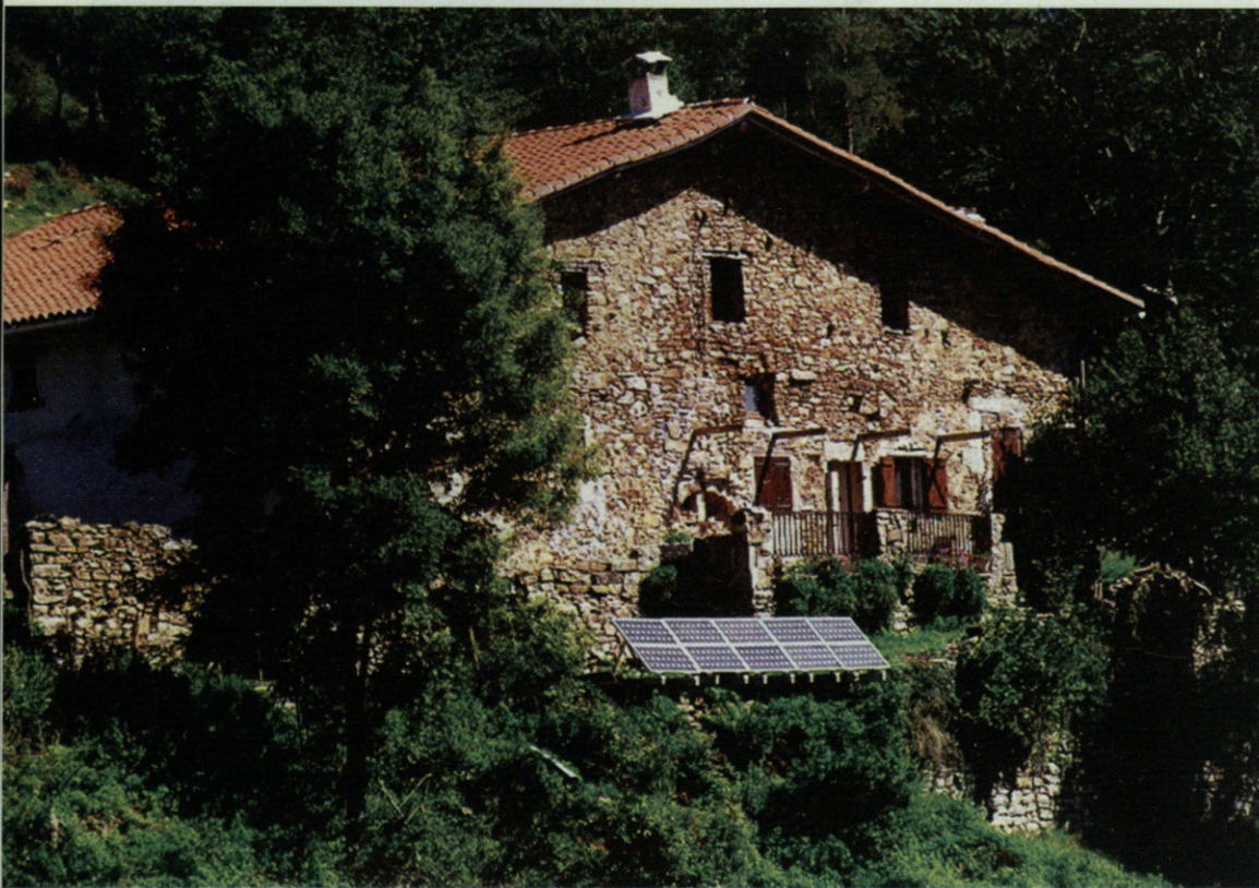
■ Sare elektrikotik urruti dauden gunetan ezartzen dira instalazio fotovoltaikoak batik bat.
