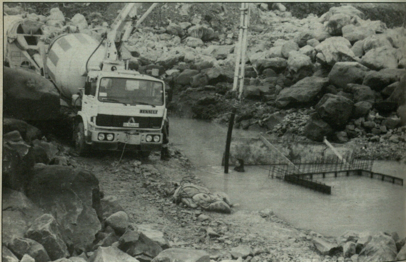
Hormigonera prestaturik, hondoa barrenatzera doa urpekaria.
