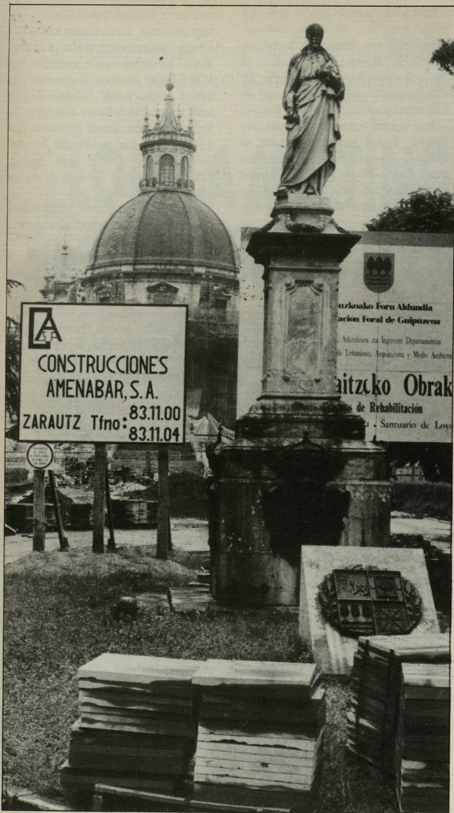
Inazio Sainduaren urteurrena medio hamaka obra eta eraikuntza egiten ari da.
