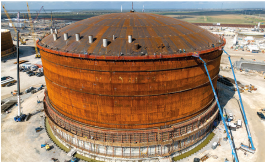
PLAQUEMINES Mississippiko deltan Venture global enpresa egiten ari den GNL plantaren tanke bateko sabaia jasotzeko momentua. 200.000 metro kubo gas biltegitratu ditzake berak bakarrik.
