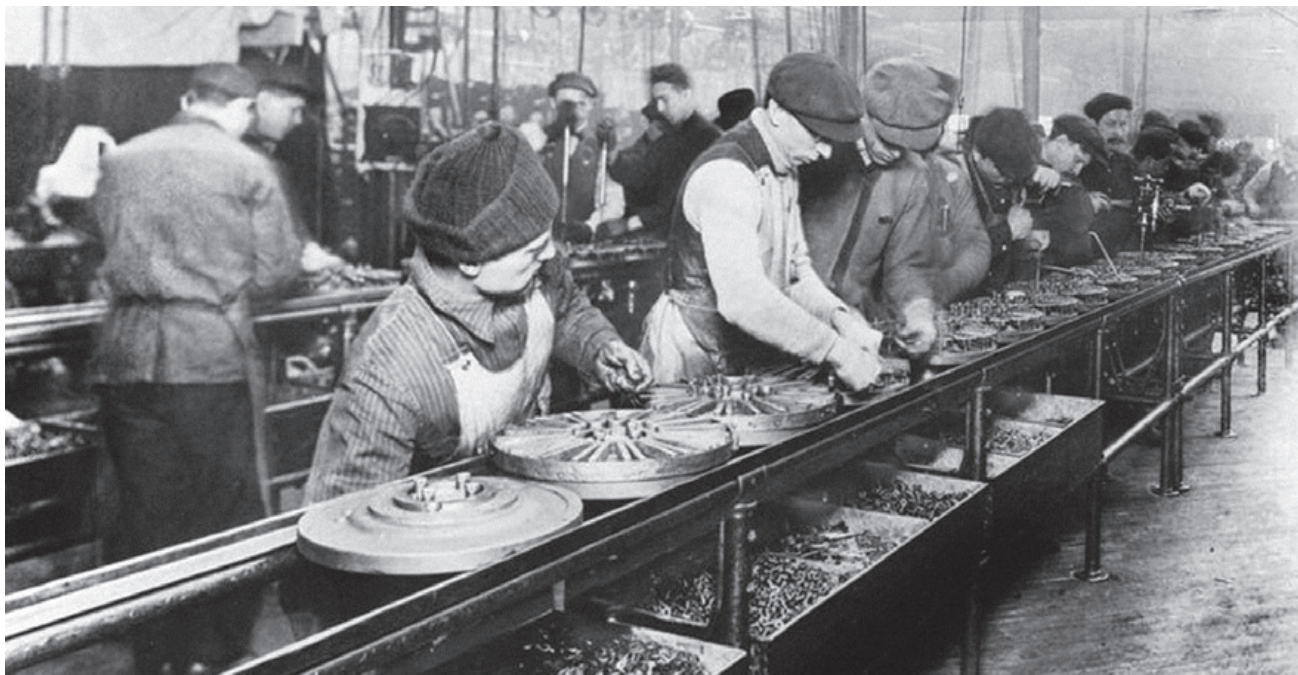
FORD AUTOMOBILAK MUNTATZEKO KATEA 1913AN. XX. MENDEKO EKOIZPEN EREDUAN LANGILEAK ZEREGIN ERREPIKAKOR ETA MEKANIKOAK EGITERA BEHARTUTA ZEUDEN. EREDU PRODUKTIBO HORREK, AUTOEZ GAIN, GIZARTE MOTA JAKIN BAT ERE EKOIZTU ZUEN.
