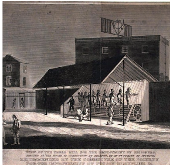
Ezkerrean, Sir William Cubitt (1785-1861) ingeniari ingelesa. Alboan, hark asmatutako arrabola, presoak zigortzeko eta otzantzeko egin. Irudiaren oinean azaltzen da makina Cubitten asmakizuna dela eta Brixtongo espetxean abiarazi zutela. "Kartzelako diziiplina hobetzeko gomendatua" zegoela ere esaten da.
