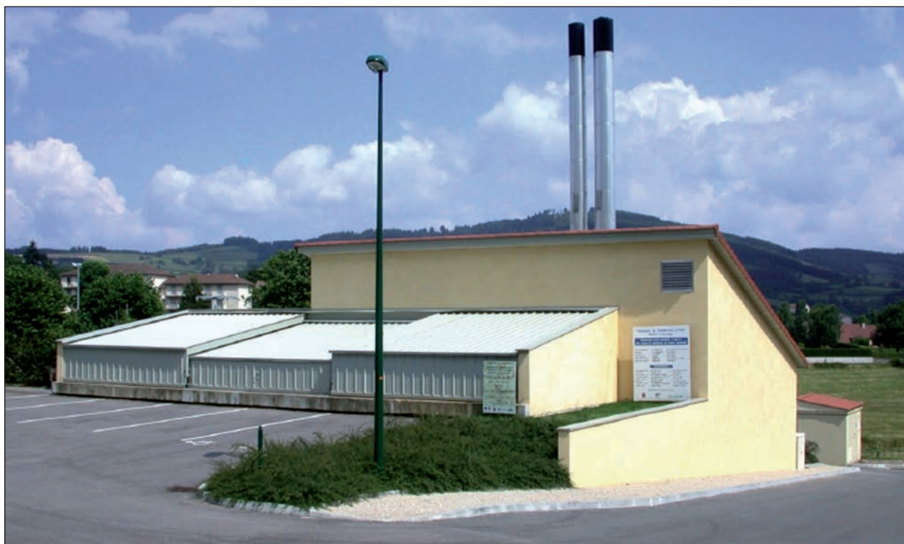
Tramayesko berogailu-gunea. Herribarneak behar duen energiaren parte handiena elikatzen du hiru sareen bidez.
