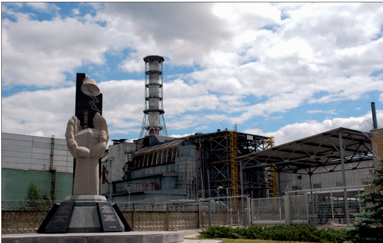
Txernobilgo 4. erreaktoreari egin beharreko estalki berriak –Munduko Zortzigarren Miraria deitu izan zaio– aspaldi behar zuten bukatuta. Lehendik duen hormigoizko sarkofagoak pitzadura larriak eta beste ditu. Kutsatzen jarraitzen du.
