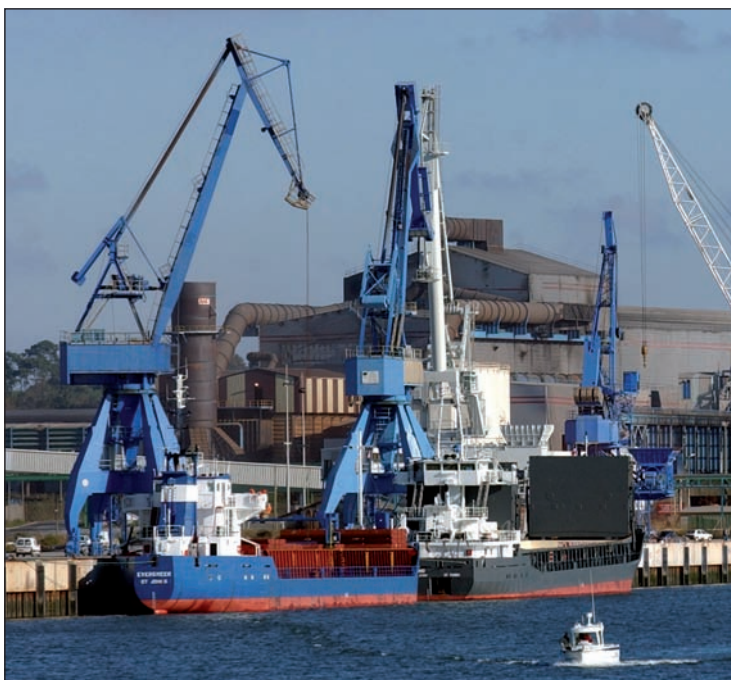
Baionako portuaren gainegitura hobetu beharra aipatu digute solaskideek.
